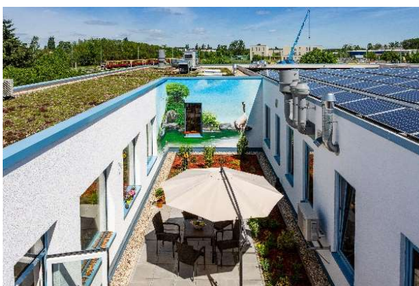
Blick vom Allresist-Dach auf Photovoltaikanlage, Gründach und Lichthof– Unser Dreiklang von Klima- und Naturschutz sowie Mitarbeiter-Pausenort
