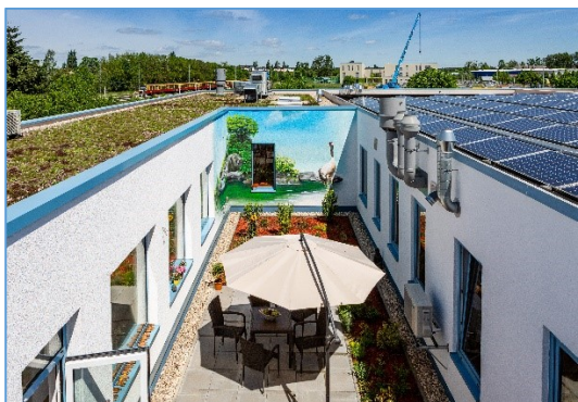
Blick vom Allresist-Dach auf Photovoltaikanlage, Gründach und Lichthof– Unser Dreiklang von Klima- & Naturschutz sowie Mitarbeiter-Pausenort
